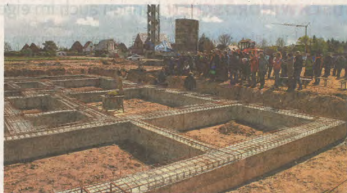
Das 3500 Quadratmeter große Baufeld und die Grundmauern für den Bau von drei Gebäuden sind vorbereitet.
