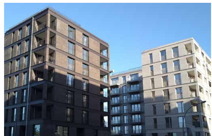
Häuser der BG Am Leuchtturm, Einklang, Gleisoase
