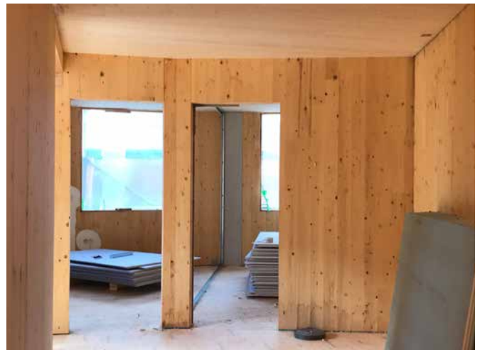
Holzmassivbauweise im BV Friedensallee
