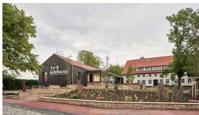
Haupthaus und Erweiterungsbau Schullandheim Barkhausen
